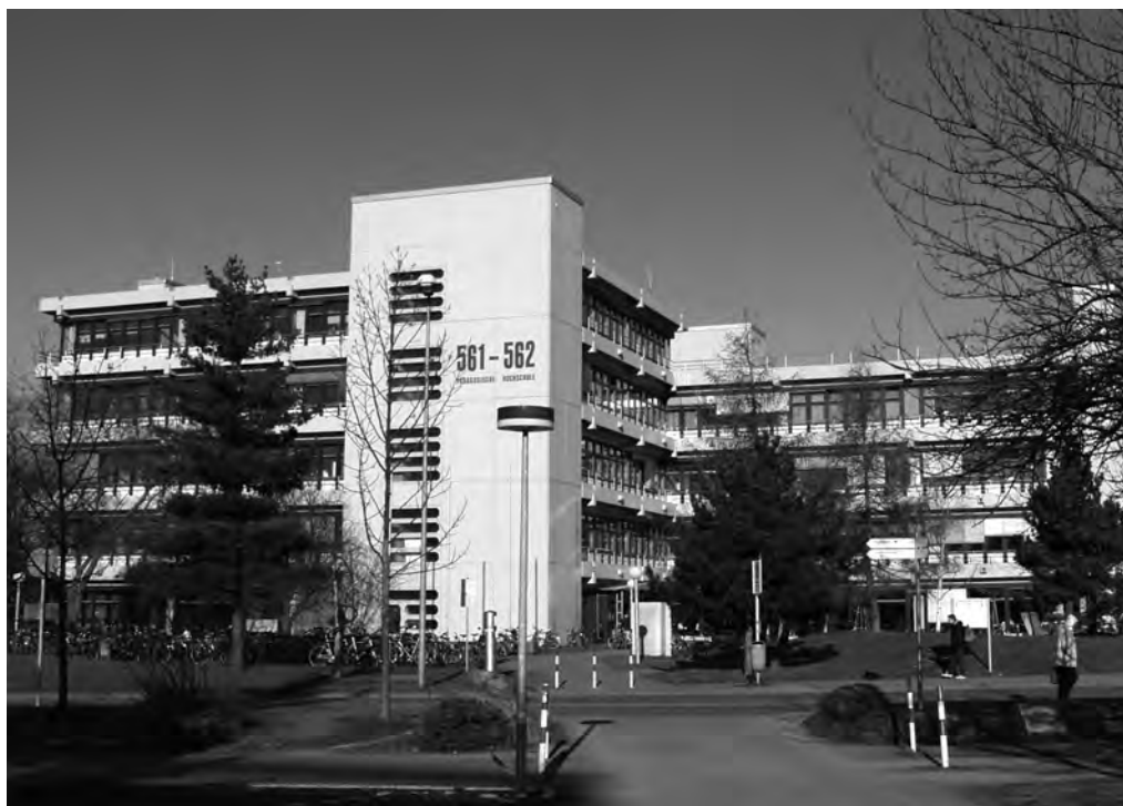
Neubau der Pädagogischen Hochschule Heidelberg auf dem Campus „Neuenheimer Feld“ Foto · Breier
